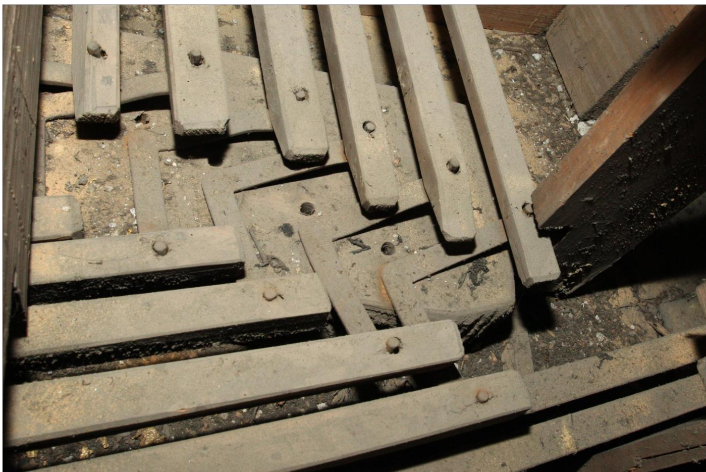
Foto č. 13: Vedení rejstříkové traktury hlavního stroje, stopy po zamýšleném jiném umístění
