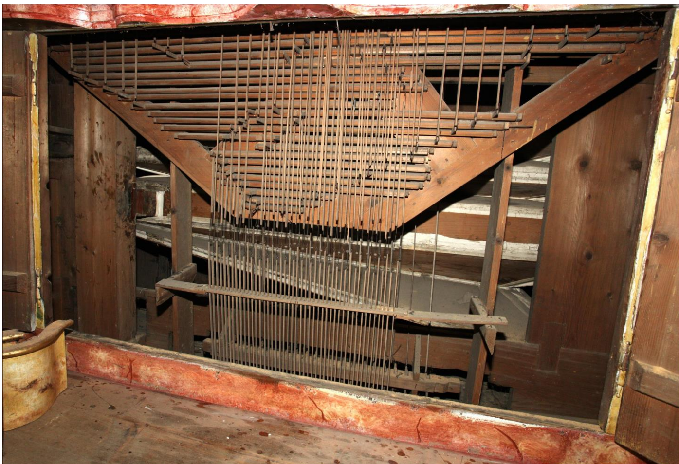
Foto č.2: Postament varhan, pohled na vedení traktur, nepůvodní měch, rozvod vzduchu, vyřezané části skříně
