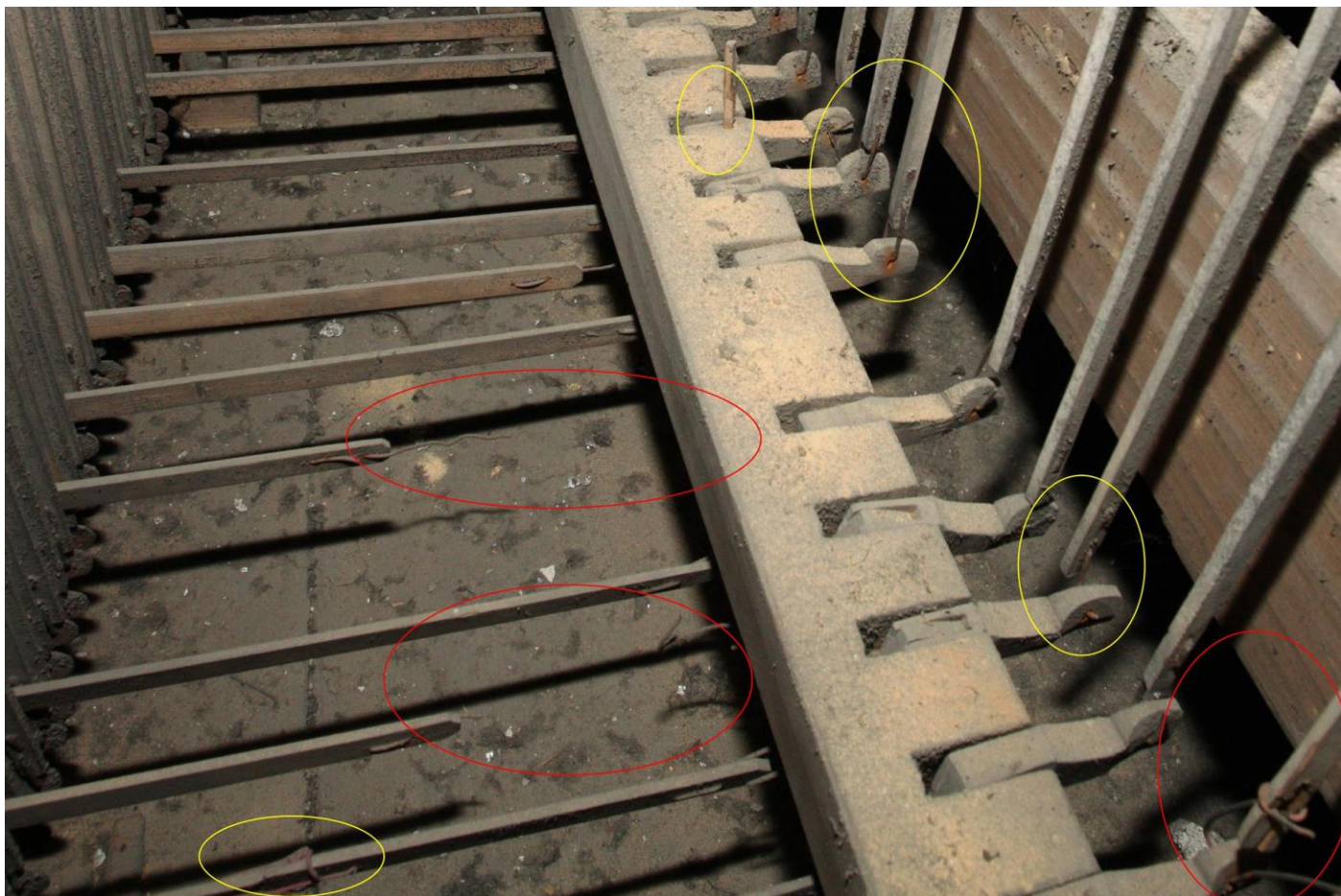
Foto č. 14: Poškození tónové traktury pedálu (přelomené dráty, provizorní vázání, koroze, opotřebování)
