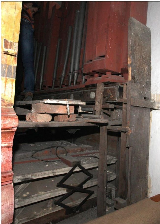
Foto č.4 : Umístění měchu, traktury k pedálu, pedálového stroje a provizorní pochozí lávky
